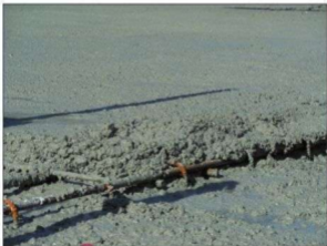
Particolare getto in corrispondenza di armatura (cospirero)
