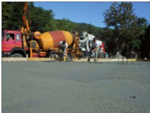
Particolare lavorazione calcestruzzo dopo il getto
