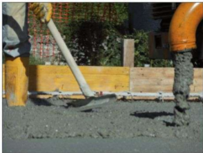
Particolare getto calcestruzzo con autopompa
