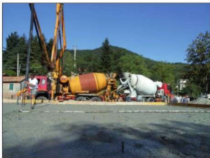
Getto calcestruzzo con ausilio autopompa
