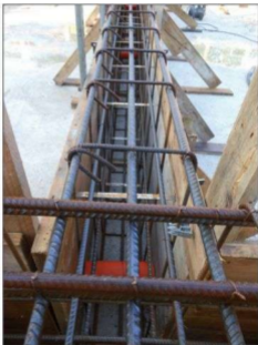
Particolare acciaio con distanziatori
